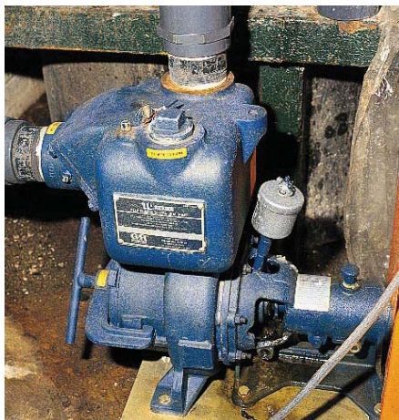
Насос 10 Series® перекачивающий твердые примеси и агрессивные жидкости в сборный резервуар на пищевом комбинате в Англии.
